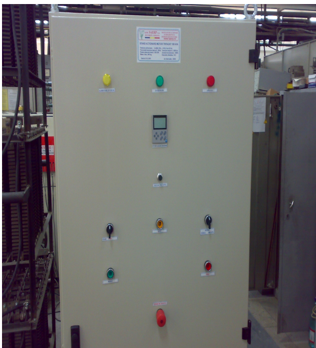
Fig. 2 Stand acționare motor trifazat 150kVA pentru atelierele CFR Pascani : a) vedere panou frontal pe ușă, b) vedere interioara dulap.
